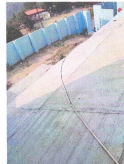
Foto 4: red de agua potable, sustitución de tubería línea principal
