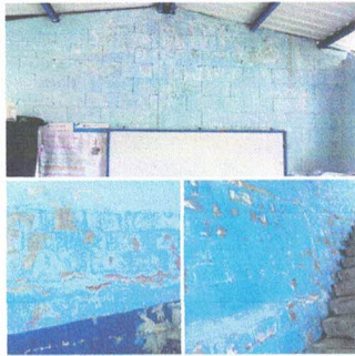
Pintura en muros exteriores e interiores y en aulas
