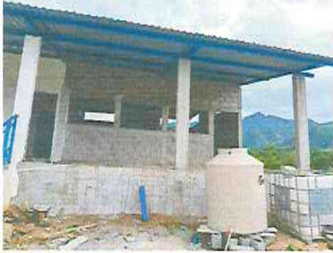
Foto 1: Sustrucción de lamina por lamina troquelada de aluzinc.
