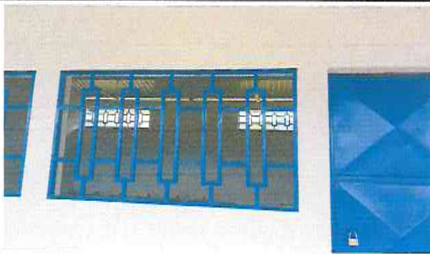
Foto 5: Sustrucción de balcones de metal.
