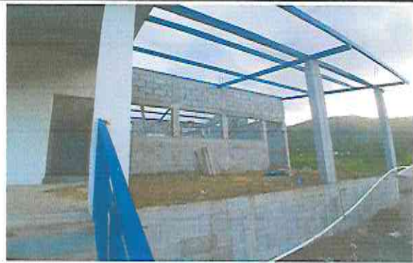
Foto 4: Reparación de muro de block.
