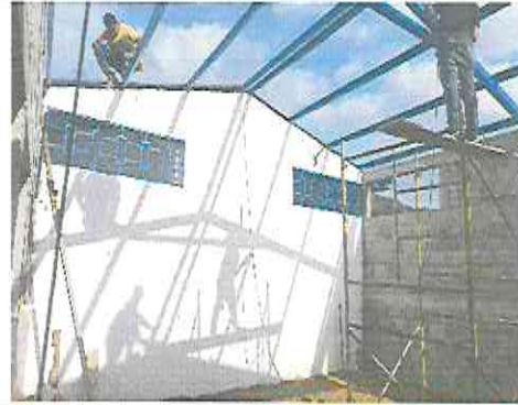
Foto 2: Sustitución de estructura metalica por metal.
