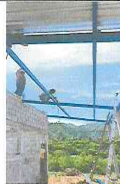
Foto 4: Reparación de muro de block.
