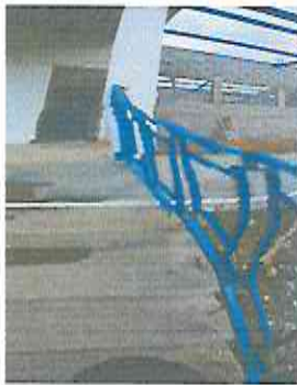
Foto 3: Sustitución de baranda de metal.
