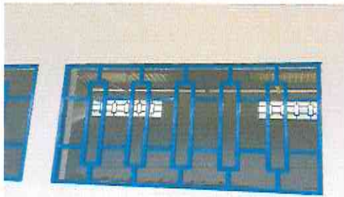
Foto 5: Sustitución de balcones de metal.
