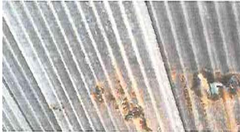
1.1 sustitución de lamina por lamina troquelada de aluzinc
