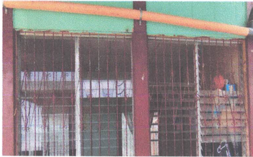
Foto 3: Mantenimiento a marcos de aluminio mill finish
