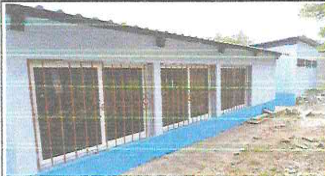
INSTALACION DE VENTANAS PVC EN AULAS
