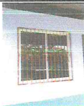
INSTALACION DE VENTANAS PVC EN DIRECCION
