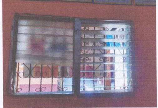
Foto 2: Sustitución de paletas de vidrio en ventanas de una aula
