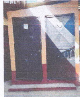
Foto 8: Mantenimiento a estructuras de puertas de metal
