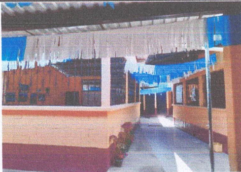
Foto 3: Mantenimiento a estructura de balcones de metal
