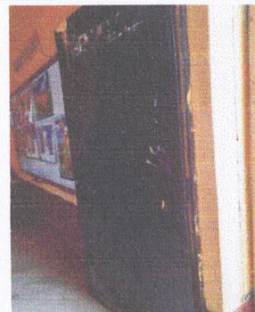
Foto 4: Mantenimiento a estructuras de puertas de metal
