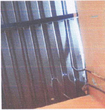
Foto 1: Sustitución de lámina, por lámina troquelada aluzinc con tornillera de fijación
