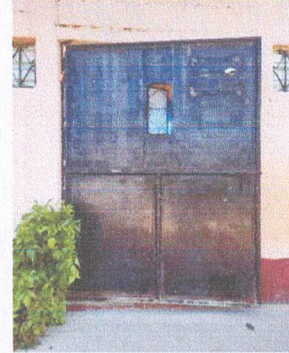
Foto 16: Mantenimiento a porton de metal
