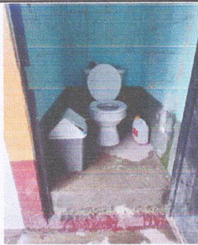
Foto 9: sellado de filtraciones de agua en paredes de sanitarios
