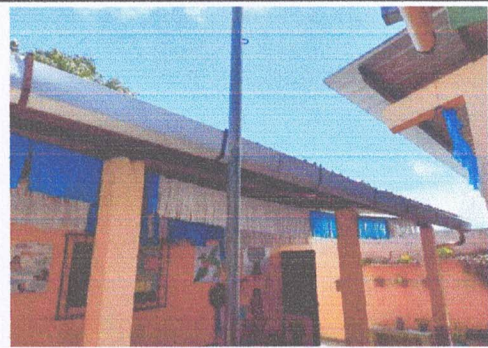
Foto 12: Sustitución de canal de metal
