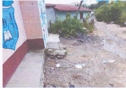
Foto 14: Reparación de banquetas de concreto
