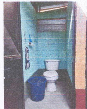
Foto 10: Sustitución o Instalacion de piso cerámico en sanitarios
