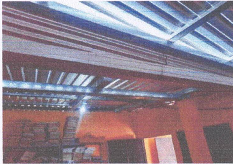
Foto 13: Sustitución de soporte o pescante de metal para canal
