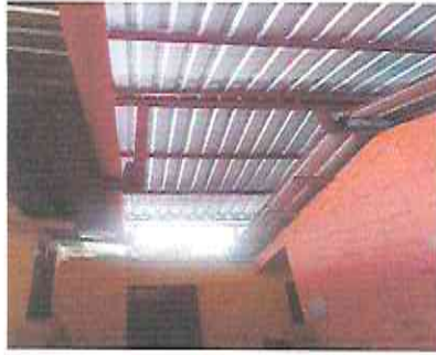
Foto 1: Sustitución o instalación de estructura de soporte. Sustitución o instalación de lamina troquelada.
