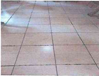
Foto 3: Sustitución o instalación de piso cerámico, mantenimiento de ventanas, mantenimiento de balcones, mantenimiento de puertas de metal, sustitución de chpas, sustitución de puerta.
