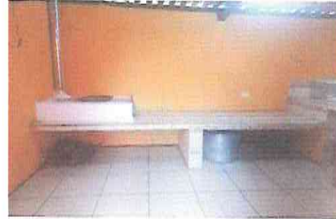
Foto 4: Sustitución o instalación de lamina troquelada, sustitución de piso cerámico, sustitución de estufa rural, pintura interiores y exteriores.
