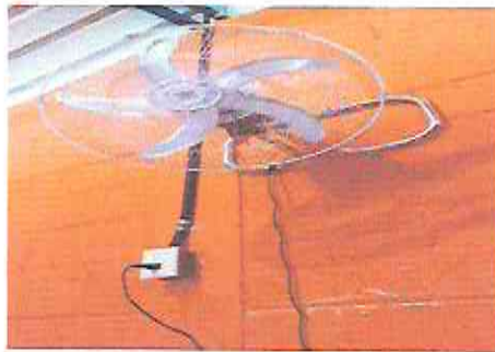
Foto 5: Sustitución o instalación de ventiladores de pared.
