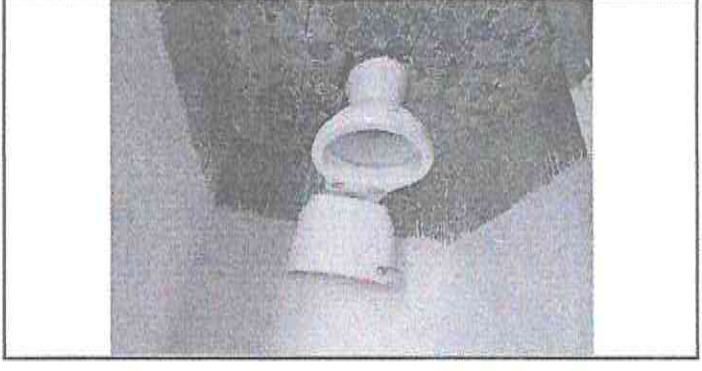
Foto 5: sanitarios dañados, se propone la sustitución de los mismos, tomar en cuenta que en el área de baños de niños los drenajes presentan obstrucción, se plantea la reparación del mismo.
