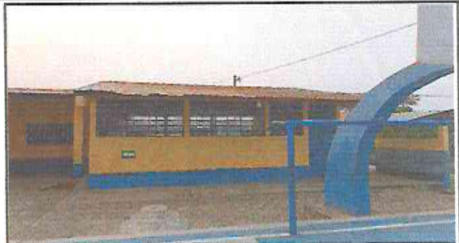
CAMBIO DE LAMINA EN AULA MODULO C 108 M2
