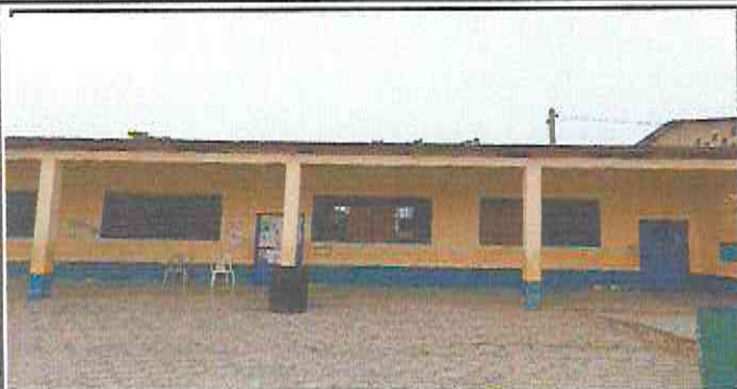
CAMBIO DE LAMINA EN AULA MODULO D 170 M2
