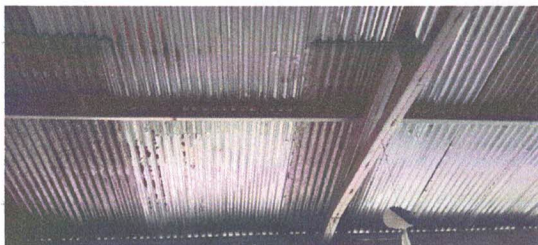
1.5 Sustitucion de lamina por lamina troquelada /
