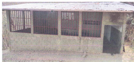
1.4 Colocacion de canal /
