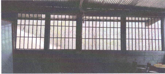
1.7 Mantenimiento de balcones de metal /
