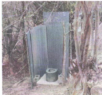
3. Reconstruccion del sanitario /
