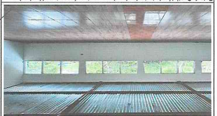
Foto 1: Sustitución de torta de piso de concreto más construcción de piso cerámico.
