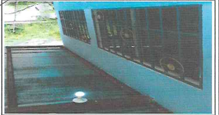
Foto 7: Instalación de luminaria (plafoneras, foco, alambre y ducto).
