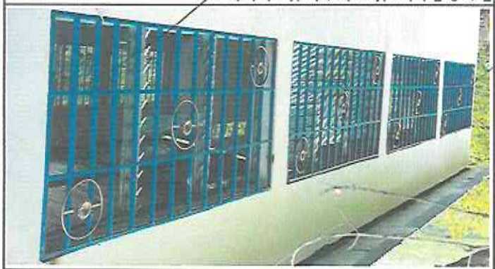
Foto 2: Fabricación e instalación de balcones.
