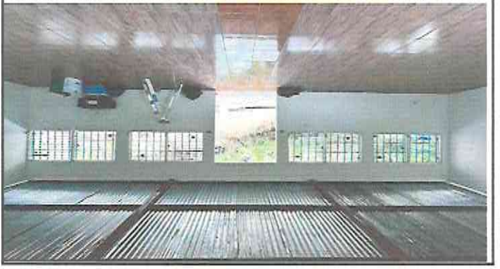
Foto 3: Fabricación e instalación de ventanas de 2,2 m. de ancho y 1,50 m. de alto.
