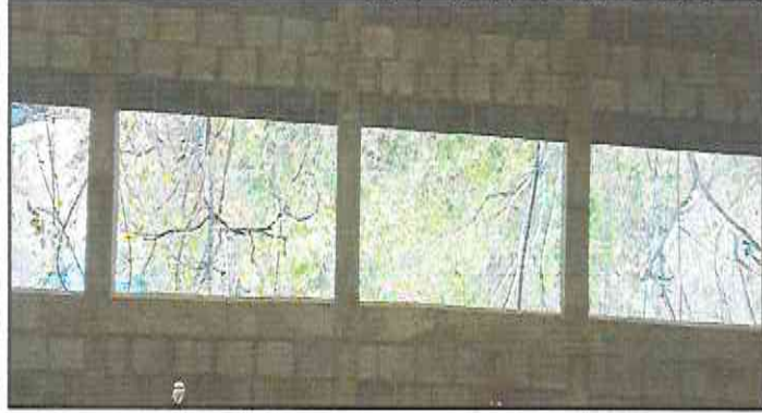
Foto 2: Fabricación e instalación de balcones.
