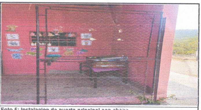
Foto 5: Instalacion de puerta principal con chapa
