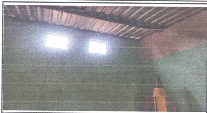
Foto1: Ampliacion de vetanas en aula #1
