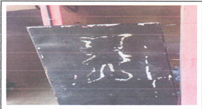
Foto 4: Arreglo de puerta de baño
