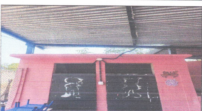
Foto 4: Instalacion de Rotoplas
