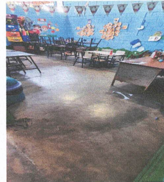
Foto 4: INSTALACION DE PISO CERAMICO MATE DE ALTA RESISTENCIA DE PEI 4.
