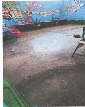
Foto 2: INSTALACION DE PISO CERAMICO MATE DE ALTA RESISTENCIA DE PEI 4.
