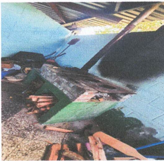
FOTO 5. SUATITUCION DE ESTUFA RURAL COMPLETA INCLUYE CHIMENEA Y
