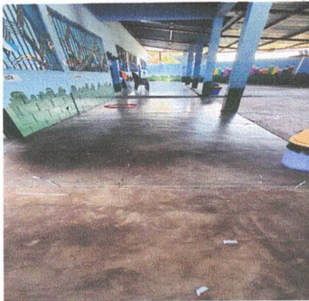
Foto 3: INSTALACION DE PISO CERAMICO MATE DE ALTA RESISTENCIA DE PEI 4.
