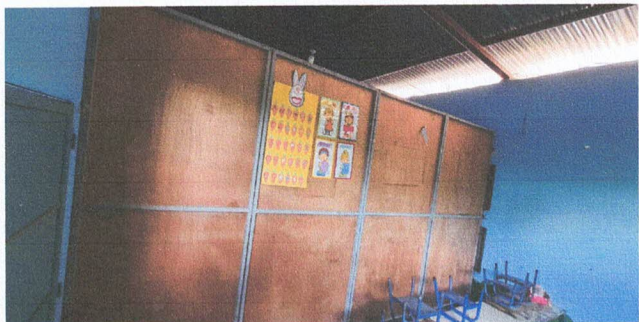
FOTO 7: MEJORAMIENTO PREFABRICADO DE PLANCHAS DE CEMENTO.
