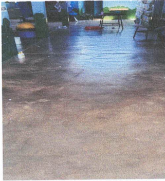
Foto 1: INSTALACION DE PISO CERAMICO MATE DE ALTA RESISTENCIA DE PEI 4.
