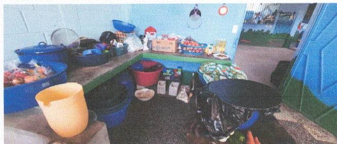
FOTO 8: INSTALACION DE AZULEJO EN MUEBLE DE CONCRETO.
