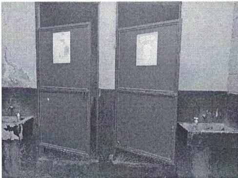
Foto 3: puertas en mal estado y lavamanos dañados, se construira mueble para instalar 4 lavamanos.
