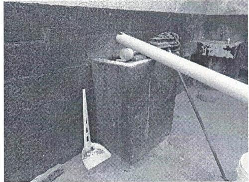
Foto 4: lavamanos de concreto dañado, muro sin acabado y piso dañado.
