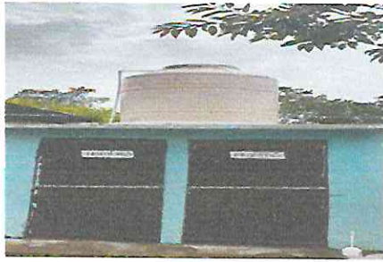
Foto 1: Albañil coloca la tubería al rotoplas y sus accesorios.
