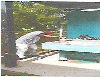
Foto 3: Albañil coloca la tubería para el chorro de la pila
