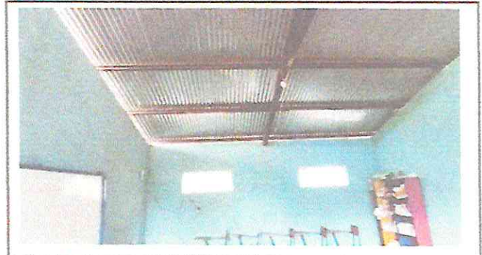
Foto 2: Sustrucción de lamparas, plafoneras, tomacorriente, apagadores, flipon y cableado eléctrico.
