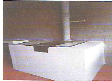
Foto 10: Instalación de azulejo en estufa Rural
