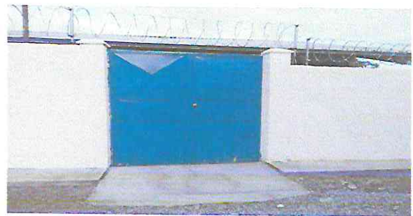
Foto 12: Sustitución e instalación de portón de metal de ingreso
