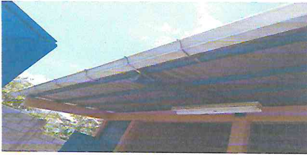
Foto 7: Colocar bajada de agua pluvial tubo PVC 3"
