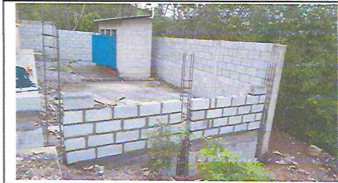
Foto 1: Reparación de muro perimetral con columnas
