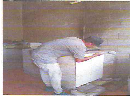
Foto 10: Instalación de azulejo en estufa Rural
