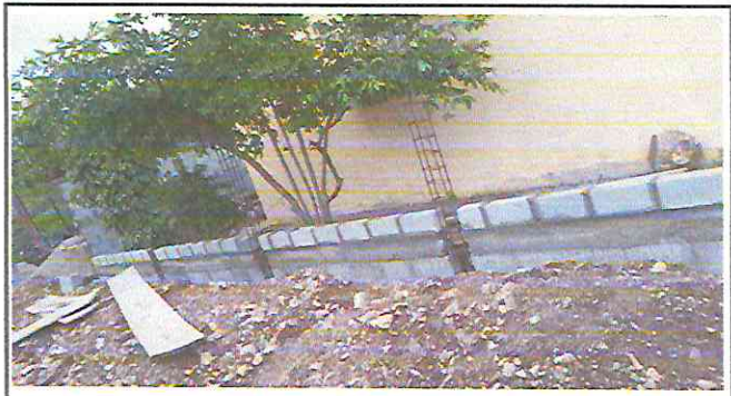
Foto 2: Reparación de muro perimetral con columnas
