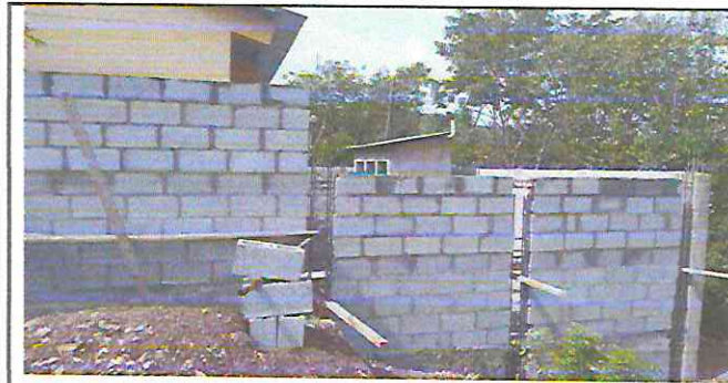
Foto 5: Reparación de muro perimetral de block y malla con columnas
