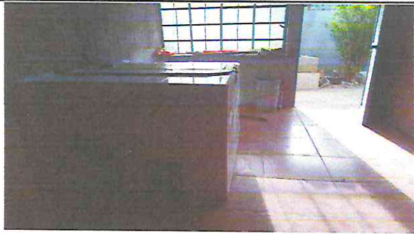
Foto 11: Instalación de piso ceramico de buena calidad PEI 5 con pegamento especial
