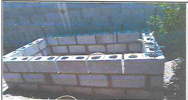
Foto 6: Sustitución de pila de cemento de dos labaderos por pila de concreto
