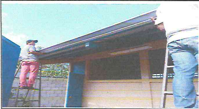
Foto7: Colocar bajada de agua pluvial tubo PVC 3"
