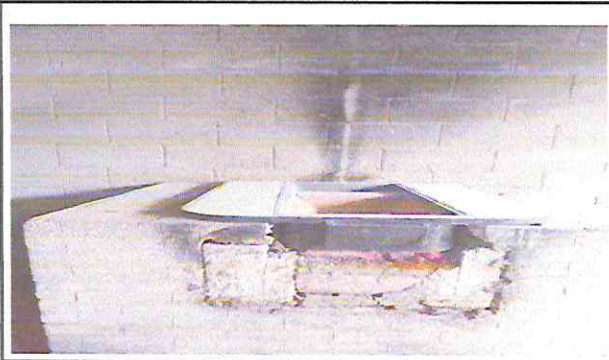
Foto 8: Sustitución de estufa Rural ahorradora con plancha de metal
