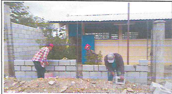
Foto 4: Reparación de muro perimetral con columnas
