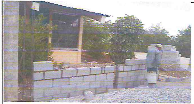
Foto 3: Reparación de muro perimetral de block con columnas
