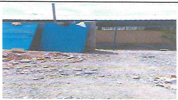
Foto 12: Sustitución e instalación de portón de metal de ingreso
