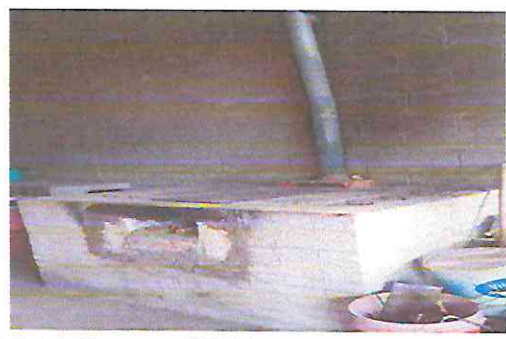
Foto 9: Sustitución de chimenea de metal por chimenea de concreto
