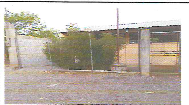
Foto 4: Reparación de muro perimetral de block y malla con columnas
