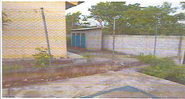
Foto 1: Reparación de muro perimetral de block y malla con columnas
