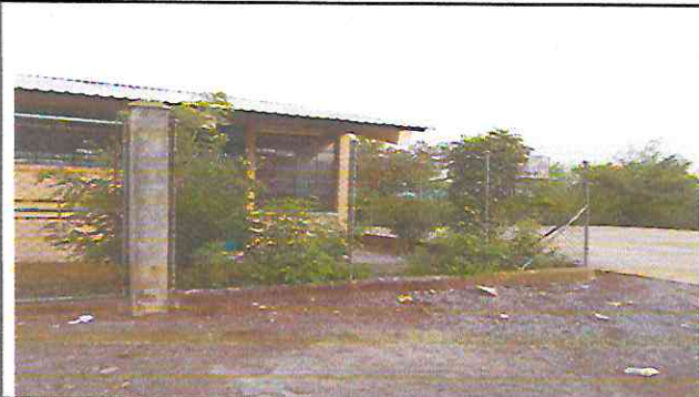
Foto 3: Reparación de muro perimetral de block y malla con columnas
