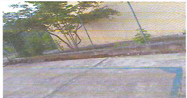
Foto 2: Reparación de muro perimetral de block y malla con columnas
