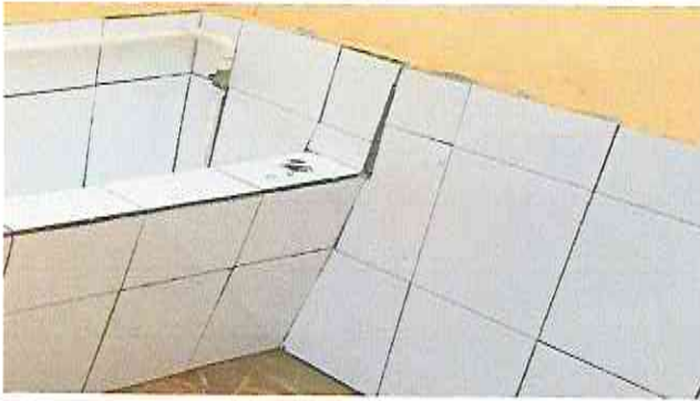
Foto1: Colocación azulejo en mingitorio
