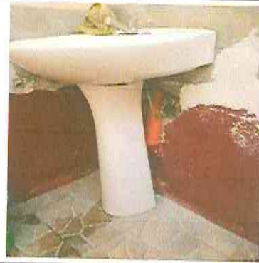
Foto 10: Instalación de lavamanos
