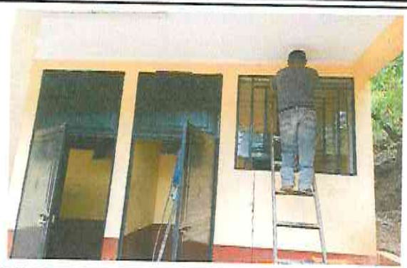
Foto 8: Pintura en general de balcones
