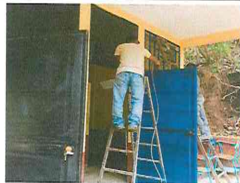
Foto 6: Pintura de puertas
