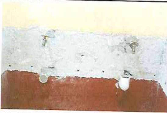
Foto 9: Demolición de lavamanos de concreto
