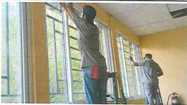
Foto 3: Sustitución de persianas por ventanas PVC de 2.29 x 1.80 mts cada una
