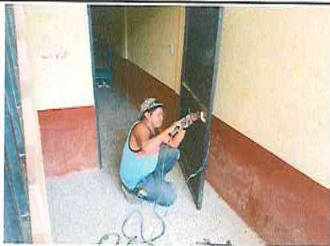
Foto 5: Sustitución de chapas
