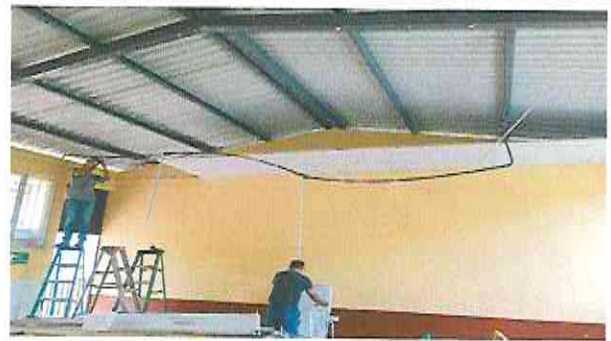
Foto 4: Instalación cielo falso en el aula de computación
