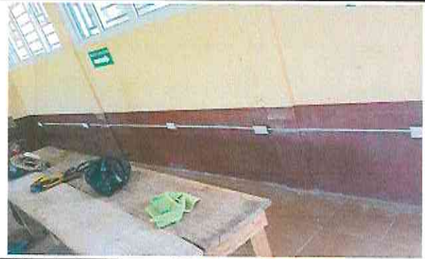
Foto 2: instalación de tomacorriente en aula de computación
