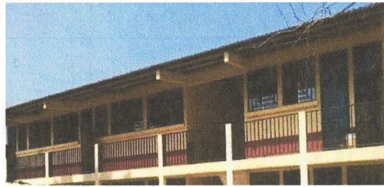
Pintura general de balcones
