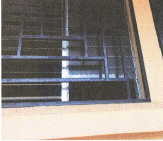
Pintura en general de barandales
