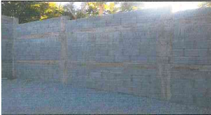
pared de muro terminado con todas la vigas terminadas
