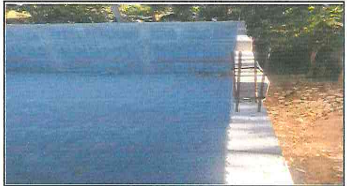
pared terminada con su viga de finalización
