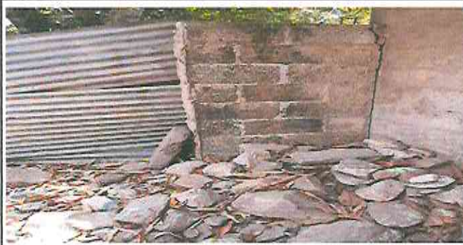
pared antes de la elaboración del muro perimetral
