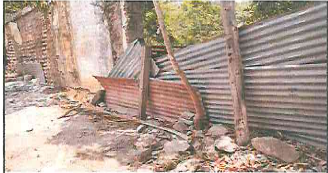
cubierta con lámina antes de la ejecución del muro perimetral
