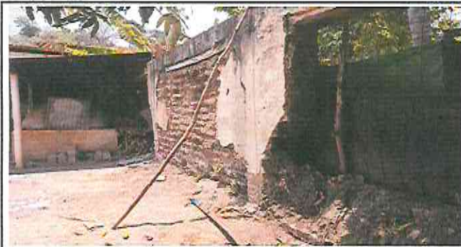
cubierta de adobe antes de la elaboración del muro perimetral
