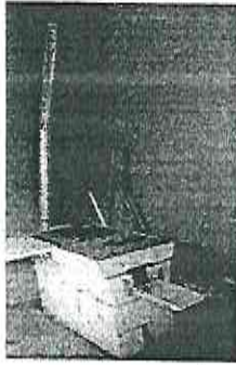
Foto 3: Fundición estufa con chimenea de concreto.
