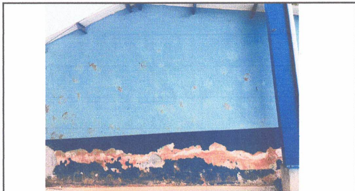
Foto 1: Demolición de cernido y colocar cernido nuevo en paredes con hongo. ✓
