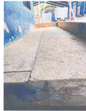
Foto 10: Instalación de piso cerámico en corredor ✓
