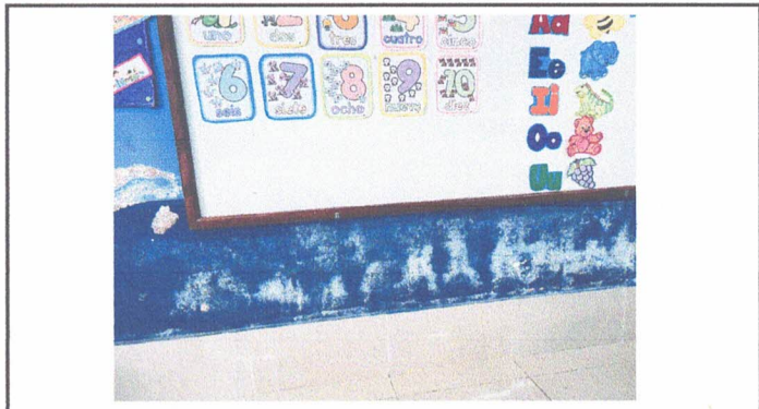
Foto 2: Demolición de cernido y colocar cernido nuevo en paredes con hongo. ✓
