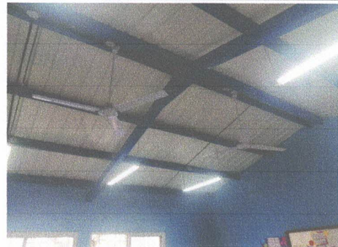
Foto 12: Sustitución de ventiladores ✓
