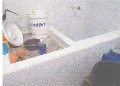
Foto 14: Reparación de pila e instalación de azulejo. /
