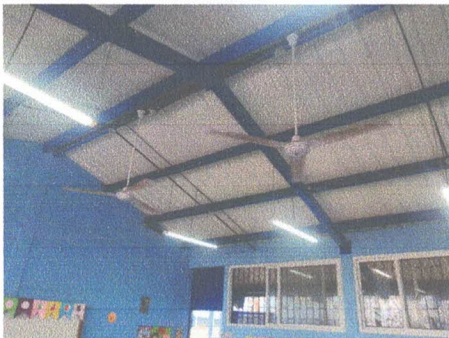
Foto 17: Sustitución de ventiladores /
