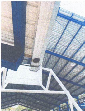
Foto 11: Reparación de bajada de agua pluvial ✓
