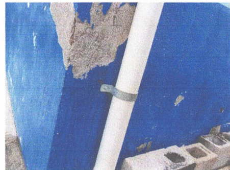
Foto 16: Reparación de pila e instalación de azulejo.
