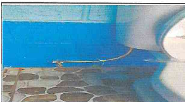
Foto 6: Instalacion de agua en baños.
