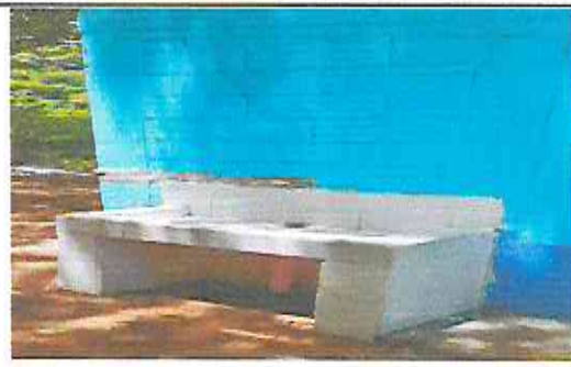
Foto 2: Instalacion de lavamanos de concreto con azulejo
