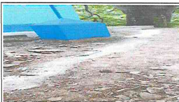
Foto 4: Sustitución de tubería lineal principal.
