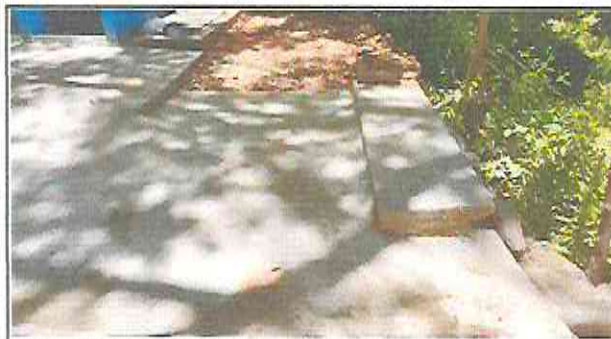
Foto 3: Sustitucion de piso de torta de concreto.
