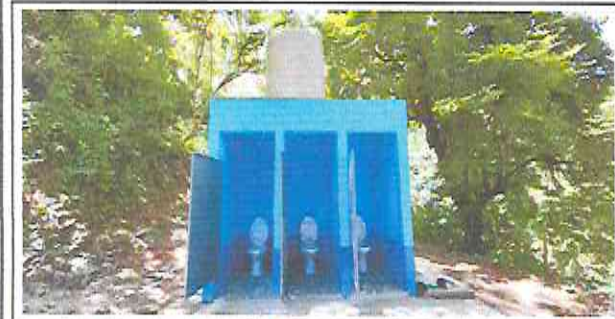
Foto 11. Sustitución de sanitarios.
