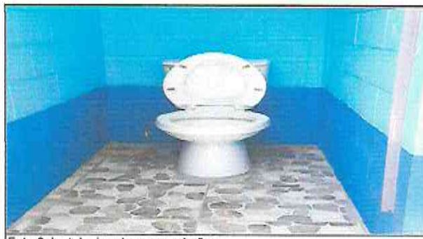
Foto 6: Instalación de agua en baños.
