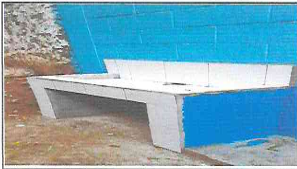
Foto 2: Instalación de lavamanos de concreto con azulejo
