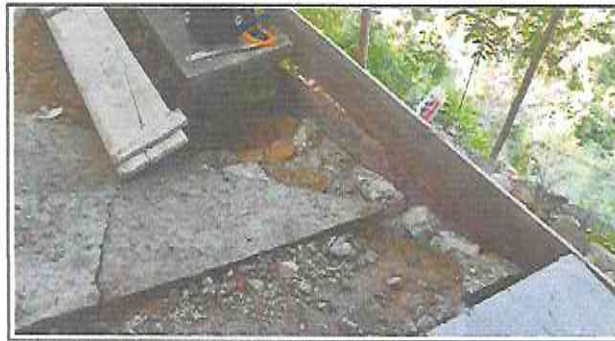
Foto 3: Sustitución de piso de torta de concreto.
