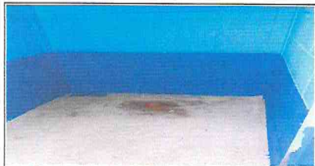
Foto 11. Sustitución de sanitarios.
