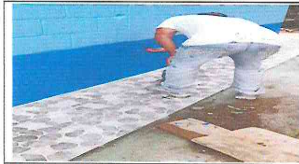
Foto 7: Pintura en muros exteriores e interiores.
