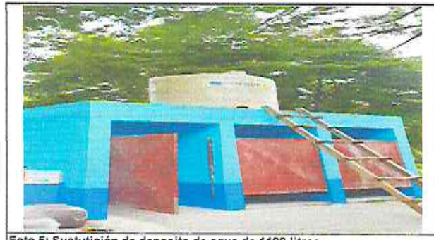
Foto 5: Sustitución de deposito de agua de 1100 litros
