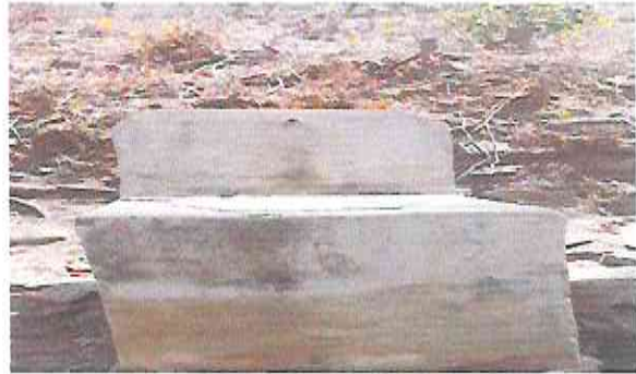
Foto 2: Instalación de lavamanos de concreto con azulejo.
