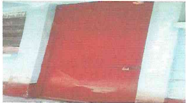
Foto 8: pintura de puertas
