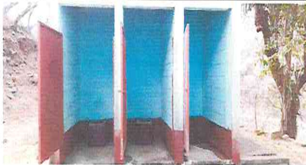
Foto 11: sustitución de sanitarios
