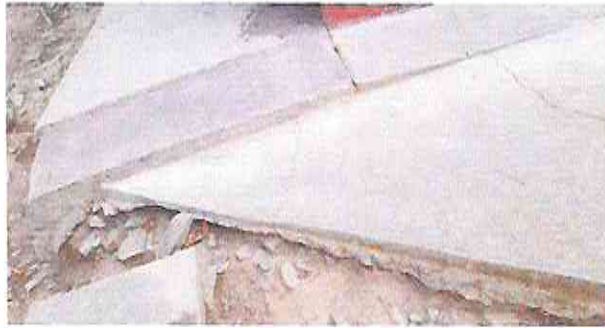
Foto 3: Sustitución de piso de torta de concreto
