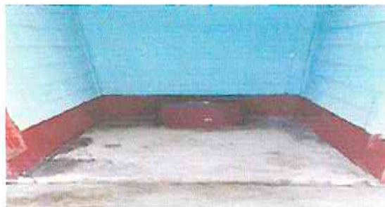
Foto 6: Instalación de agua en baños
