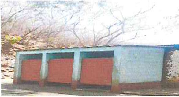
Foto 1: fundición de loza en baños para colocación de deposito de agua.
