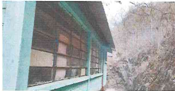
Foto 9: Fabricación e instalación de balcones de hierro en ventanas.
