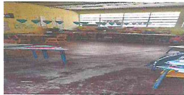
Foto 10: instalación de piso cerámico
