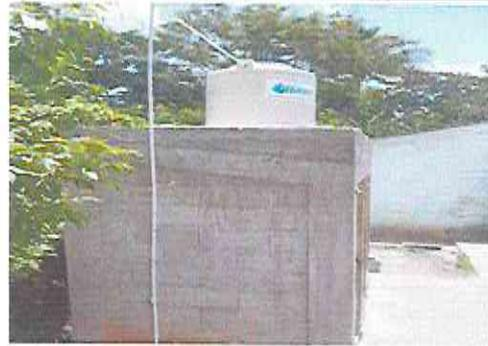
Foto 2: Colocación de tanque para agua de 1100 litros con su instalación
