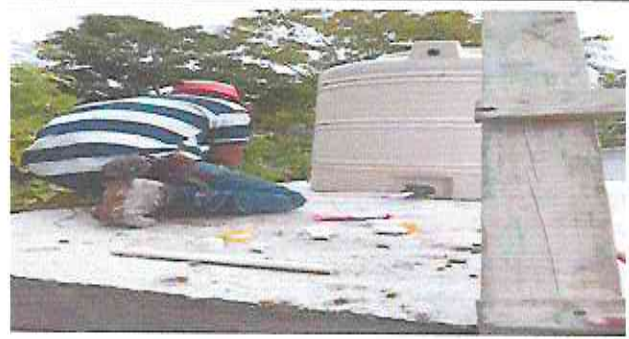
Foto 2: Colocación de tanque para agua de 1100 litros con su instalación
