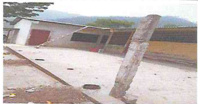
Foto 10: Sustitución de galera en corredor.
