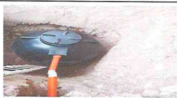
Foto 4: Instalación de drenaje hacia la fosa.
