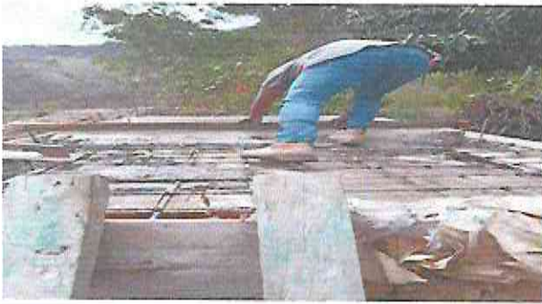
Foto1: Fundición de losa de concreto sobre los baños.
