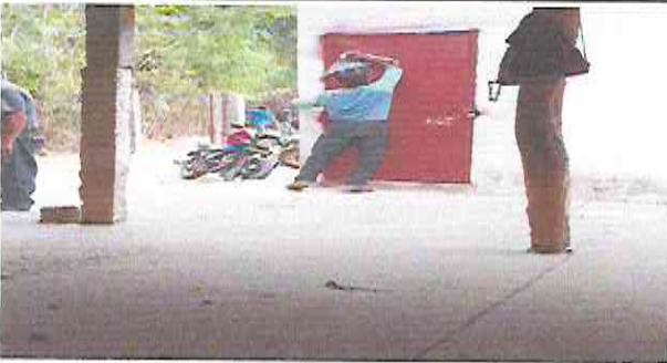
Foto 5: Reparación de puerta frente al aula.
