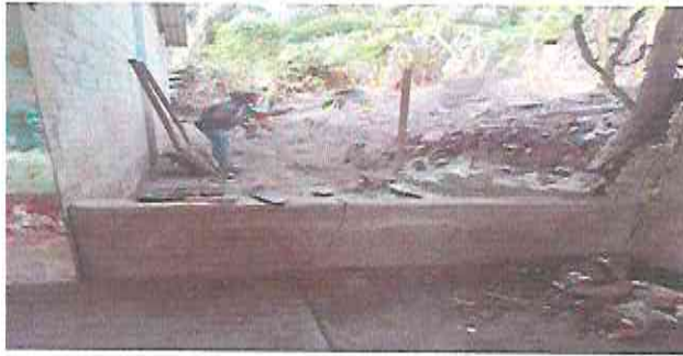
Foto 7: Demolición de muro en riesgo frente al aula.
