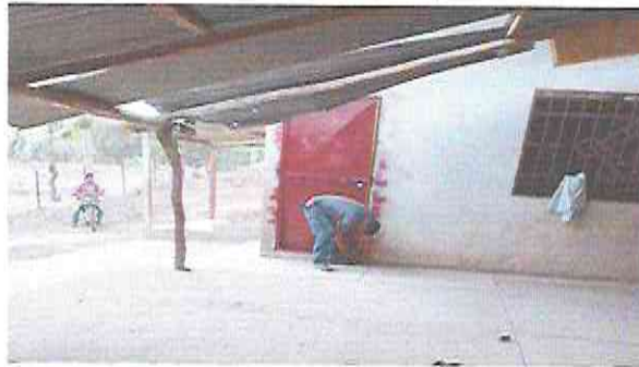
Foto 9: Sustitución de puerta en aula.
