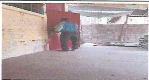
Foto 6: Reparación de puerta frente al aula.
