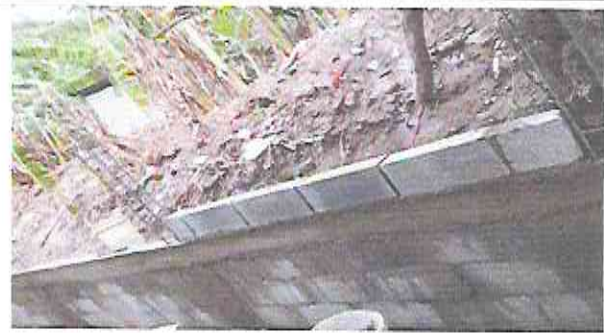
Foto 8: Sustitución de muro existente frente al aula.
