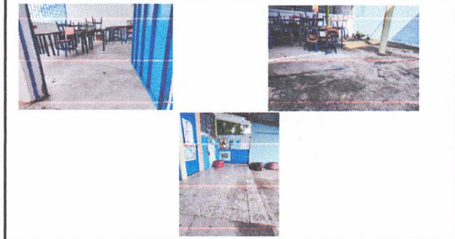
sustitución de piso de concreto liso por piso de granito
