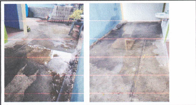
limpieza, vaciado e instalación de cifon en fosa septica, sale mal olor por estar llena
