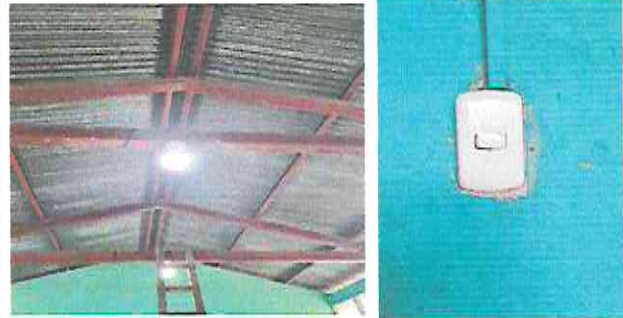
Foto 4: Sustitución de Cable Eléctrico
