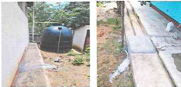
Foto 3: Instalación de tubería hacia Rotoplast
