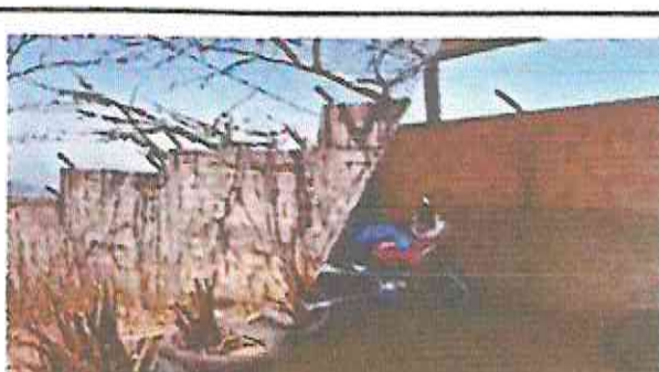
Foto 12: Repello y cernido en muro de ingreso
