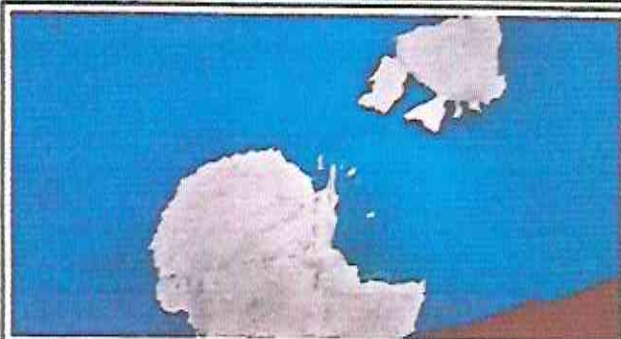
Foto 2: Demoler cervido y colocar uno nuevo en paredes
