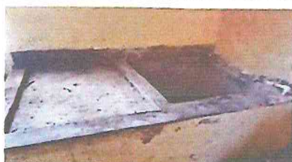
Foto 10: Instalación de azulejo en pila
