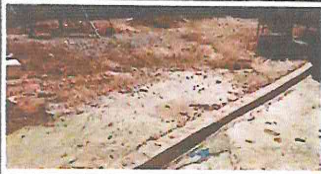
Foto 1: Torta de concreto en área de ingreso
