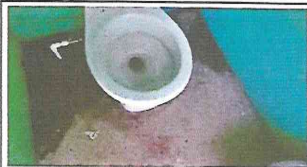
Foto 4: Sustitución de sanitarios
