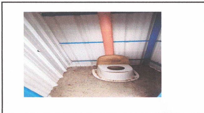
foto 3: Sustición de sanitarios
