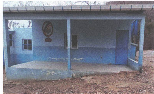
foto 12: Barandal en corredor de escuela
