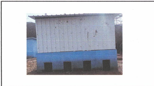
foto 1: Instalacion de drenaje de baño
