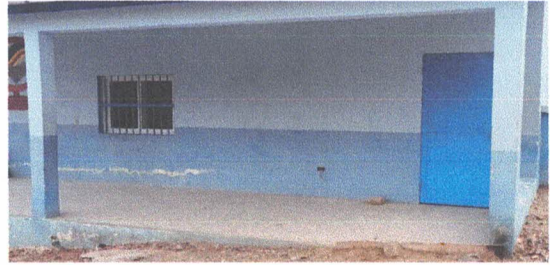
foto 8: Levantado de muro en área de corredor de la escuela
