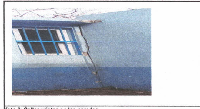
foto 6: Sellar grietas en las paredes
