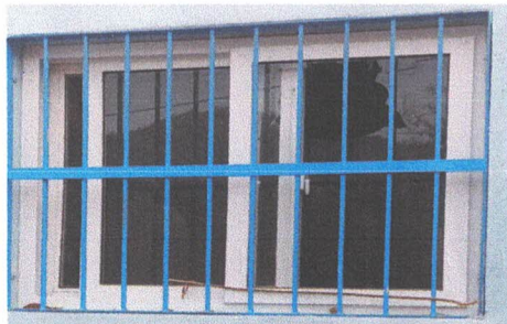
foto 11: Sustrucción de ventanas existentes de PVC por metal
