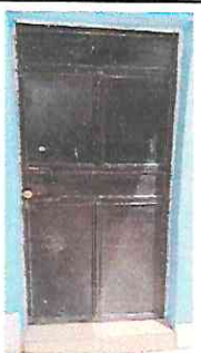
foto 5: Sustitución de Chapas
