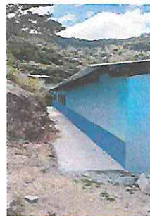
Foto 2: Fundición de banqueta en la parte de atrás
