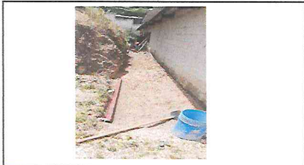
Foto 2: Fundición de banqueta en la parte de atrás
