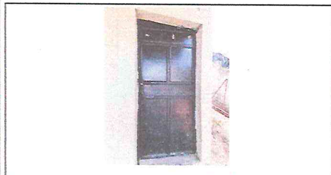
Foto 5: Sustitución de Chapas
