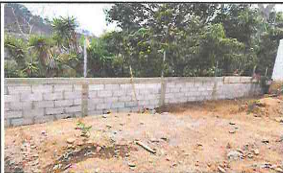
Foto 1: Muro Perimetral en la fase final.
