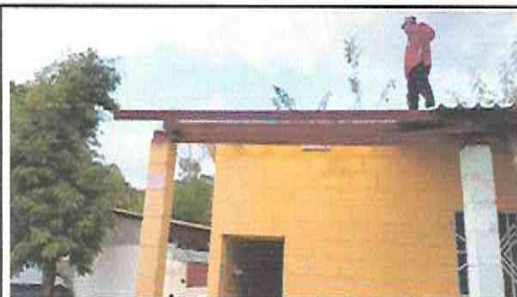
Foto 3: Estructura metalica en su etapa final
