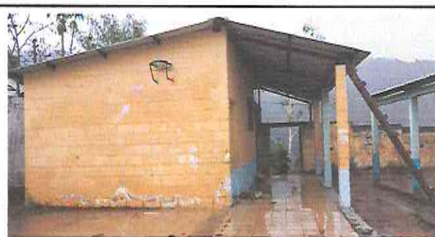
Foto 4: Estructura metalica y lamina troquelada instalada completamente
