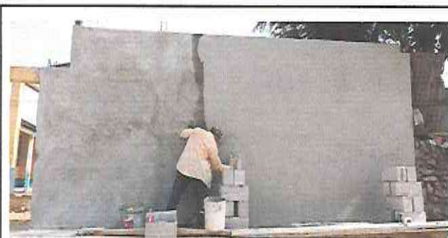
Foto 5: Cernido y Repello en la parte exterior del muro.
