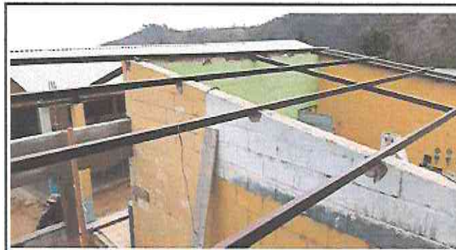
Foto 4: Colocacion de estructura metalica del salon de clases.
