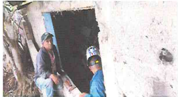
Foto 2: preparacion del lugar para instalaar el balcon.
