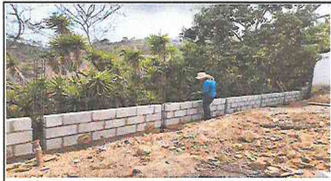
Foto 2 Avance de muro perimetral.
