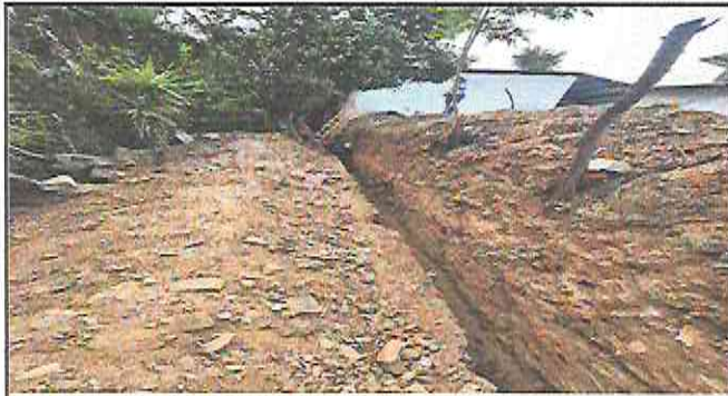
Foto 1: zanjiado para la realización del muro perimetral.
