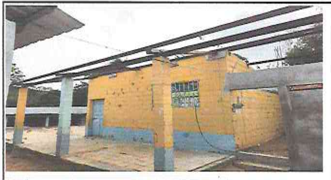
Foto 3: Avance de la intalacion del techado del aula.
