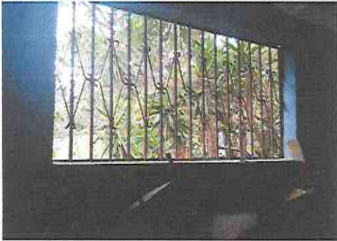
FOTO 1: Desmontaje, fabricación e instalación de balcones del aula no. 2, módulo 2
