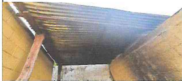
FOTO 4: Sustitución de estructura de soporte de madera por metal en cocina
