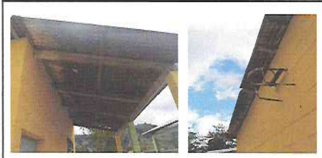
FOTO 1: Sustitución de lámina, por lámina troquelada calibre 26, desmontaje y colocación de estructura metálica
