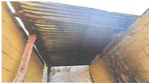
FOTO 3: Sustitución de lámina de cocina por deterioro.
