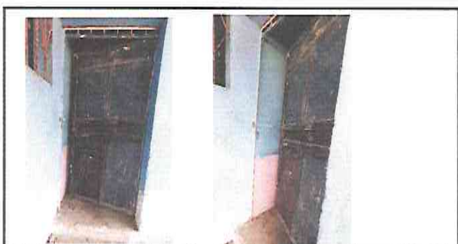
FOTO 6: Desmontaje, fabricación y sustitución de puerta de metal No. 3 de bodega
