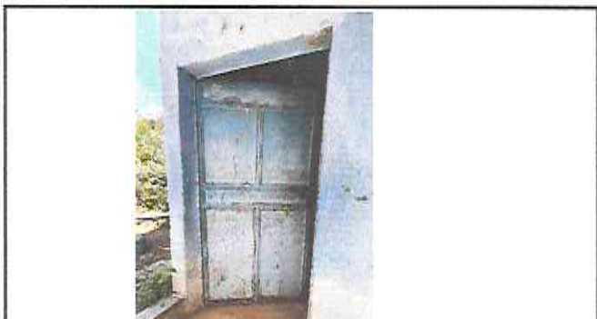
FOTO 4: Fabricación, desmontaje y sustitución de puerta de metal de aula no. 1 módulo 2
