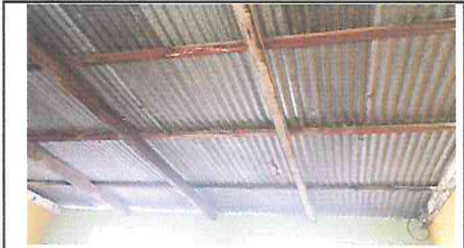
FOTO 2: sustitución de estructura de metal por la de madera, capote mas tornilleria
