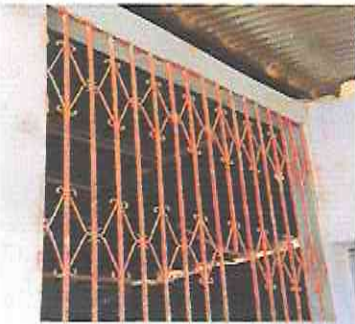
FOTO 3: Desmontaje, fabricación e instalación de balcones de metal del aula no. 2 módulo 2
