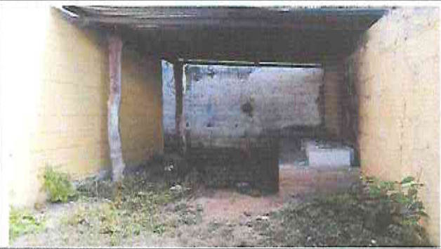
FOTO 2: Reparación de muros de cocina por deterioro
