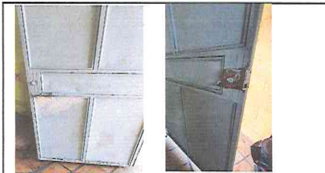
FOTO 3: Desmontaje, fabricación y sustitución de puerta de metal
