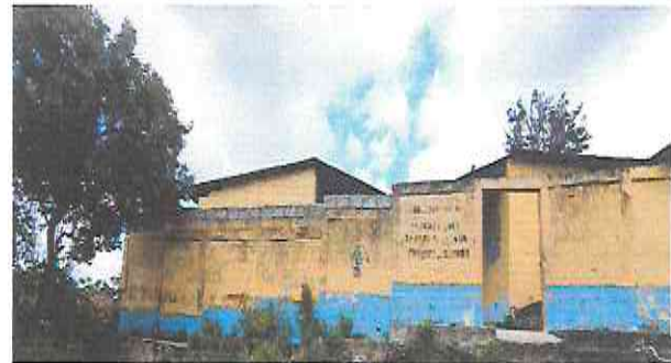
FOTO 6: Reparación de repello y cernido en muro perimetral (exterior)
