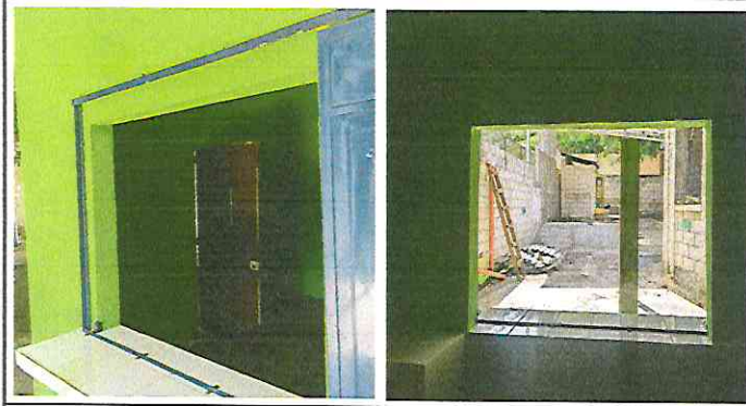
Foto 7: Cocina: Mesada en ventana con azulejo, instalación de ventana metálica.
