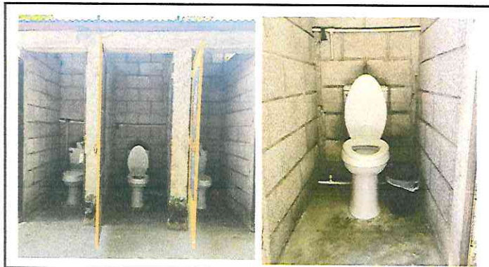
Foto 3: Baños: sustitución de sanitarios.
