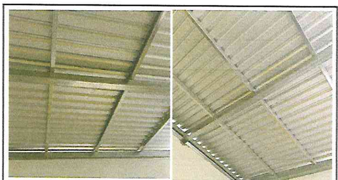
Foto 6: Cocina: Sustitución de lámina por lámina troquelada aluzin calibre 26 y sustitución de estructura de soporte de madera por metal
