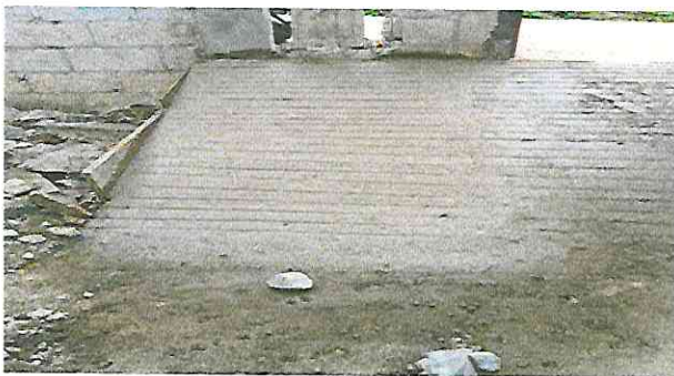
Foto 9: Ampliación de rampa de ingreso
