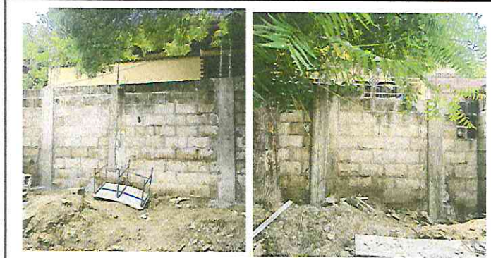
Foto1: muro perimetral: Reparación de muro perimetral.
