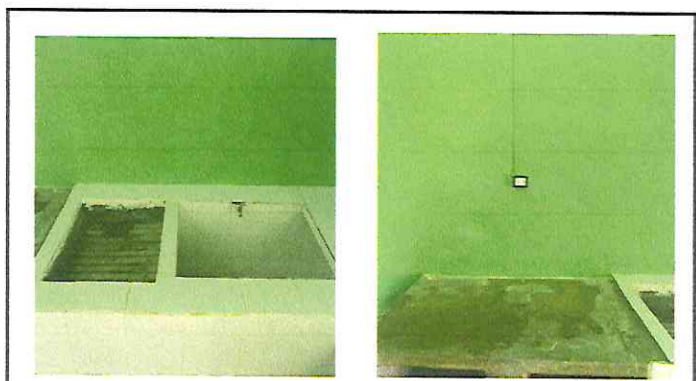
Foto 4: Cocina: Repello en muros, cernido en muros, tratamiento de humedades.
