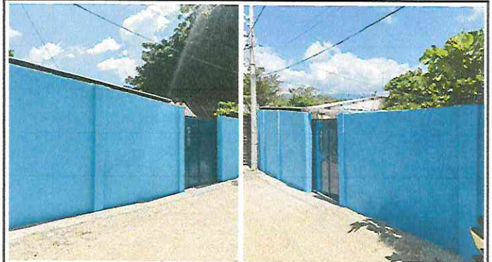
Foto 8: Pintura en muros exteriores.
