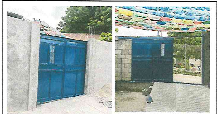
Foto 2: muro perimetral: Ampliar espacio de portón de ingreso, sustitución de portón de metal de ingreso.
