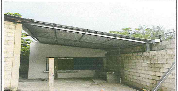
Foto 10: Area de comedor: Sustitución de lámina por lámina troquelada aluzin calibre 26 y sustitución de estructura de soporte de madera por metal.
