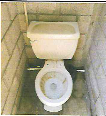
Foto 3: Baños: sustitucion de sanitarios.
