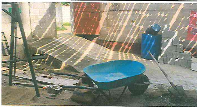
Foto 9: ampliacion de rampa de ingreso.
