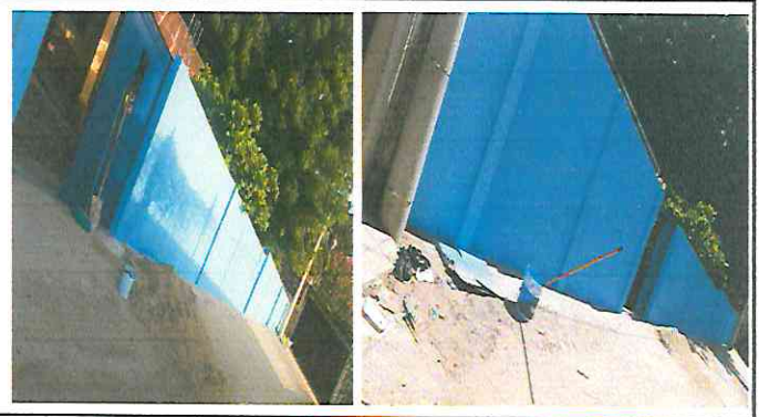
Foto 8: Pintura en muros exteriores.
