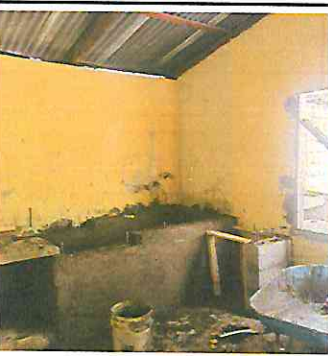
Foto 5: cocina: Instalacion de pila de concreto
