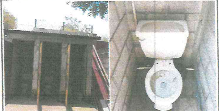
Foto 2: Baños: Sustitución de sanitarios.
