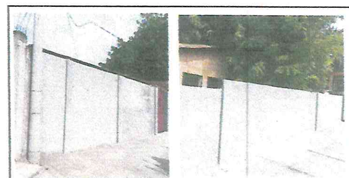
Foto 6 pintar el muro exterior
