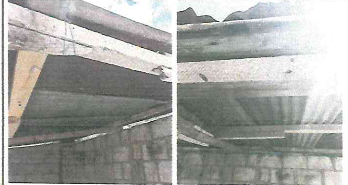
Foto 8: escenario, sustitución de lámina, por lámina troquelada aluzinc calibre 26 y Sustitución de estructura de soporte de madera por metal.
