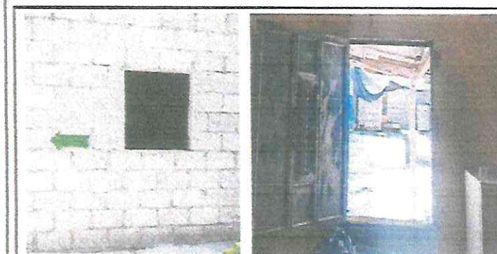
Foto 5: cocina, mesada en ventana, instalacion de ventana metalica
