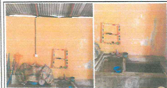
foto 3: cocina, repello en muros, cernido en muros, tratamiento de humedades
