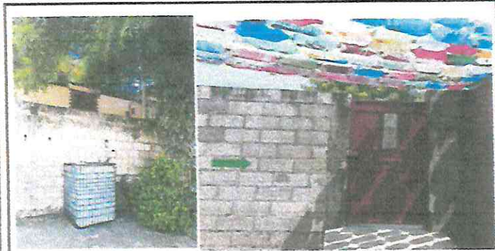
Foto 1: reparación de muro perimetral, ampliacion e instalacion de porton de ingreso
