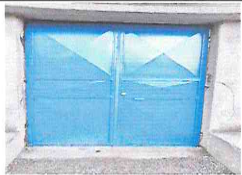
Sustitución de Portón de la entrada principal de la escuela.
