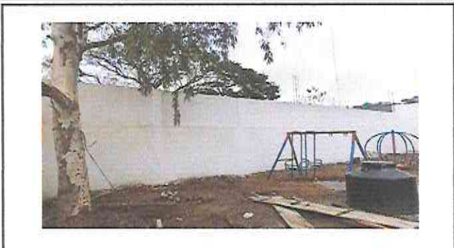
Reforzamiento de tapial con columnas de cemento área de juegos
