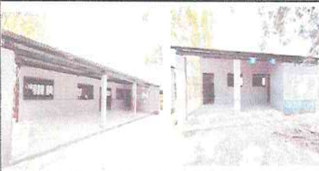
Foto 5: Pintura General de la escuela.
