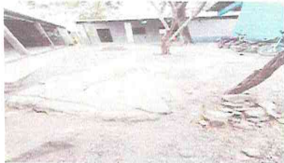
Foto 4: Fundición de torta de cemento de la entrada hacia las aulas
