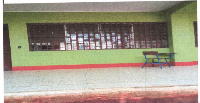
Foto 4: En esta imagen se aprecia el aula número 2, Sustitución del cable eléctrico, tomacorrientes e interruptores en planta baja
