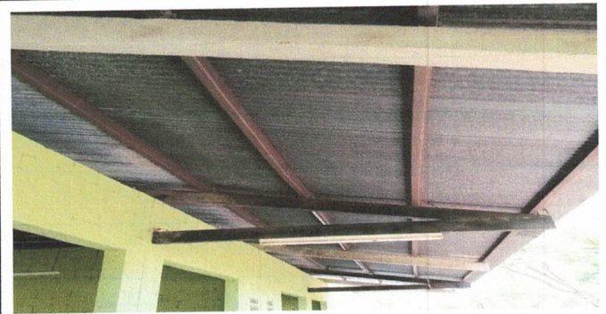
Foto 4: Sustitución de Techo en aulas del segundo nivel con lámina Troquelada calibre 26 legítima
