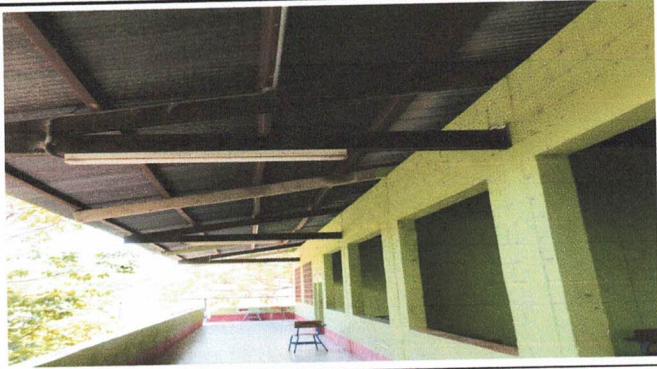
Foto 1: Sustitución de Techo en aulas del segundo nivel con lámina Troquelada calibre 26 legítima
