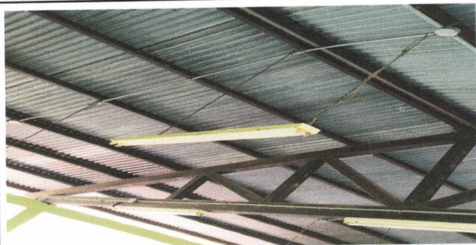
Foto 3: Sustitución de Techo en aulas del segundo nivel con lámina Troquelada calibre 26 legítima
