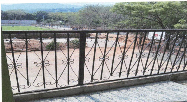
Foto 5: En esta imagen se aprecia el el barandal que será reforzado con 4 columnas lijado y pintado
