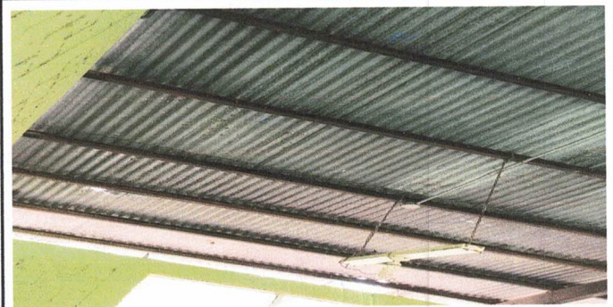
Foto 6: Sustitución de Techo en aulas del segundo nivel con lámina Troquelada calibre 26 legítima
