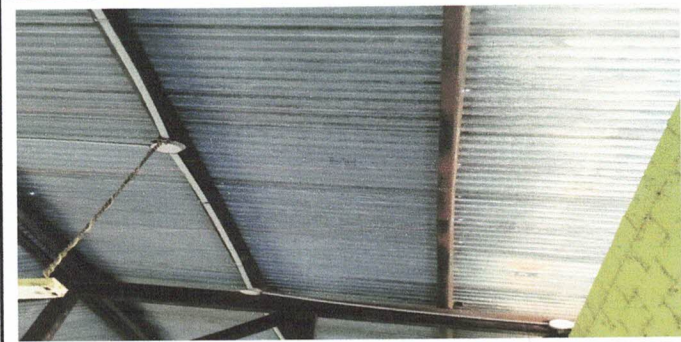
Foto 5: Sustitución de Techo en aulas del segundo nivel con lámina Troquelada calibre 26 legítima
