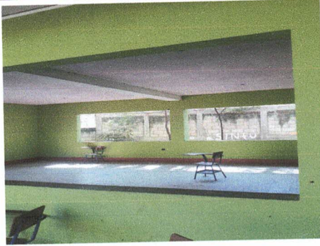
Foto 1: En esta imagen se aprecia el aula número 2, Sustitución del cable eléctrico, tomacorrientes e interruptores en planta baja
