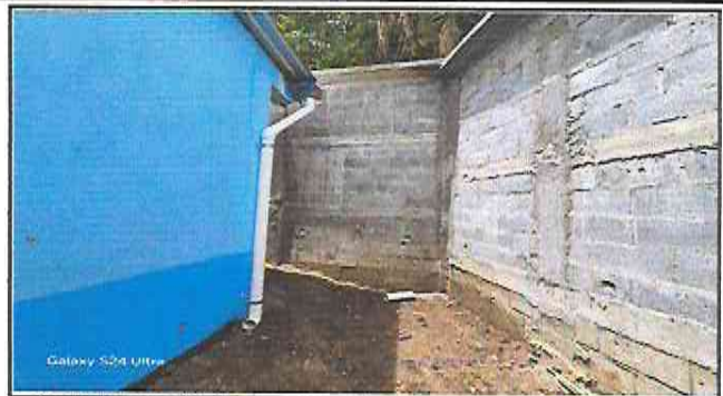
Foto 20: Reparación de muro de contención con su marquesina
