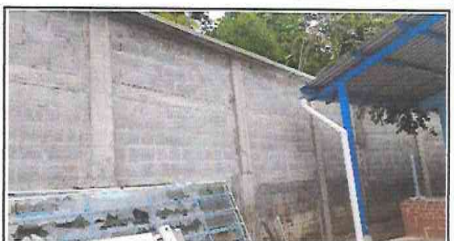
Foto 12: Reparación de muro de contención con su marquesina
