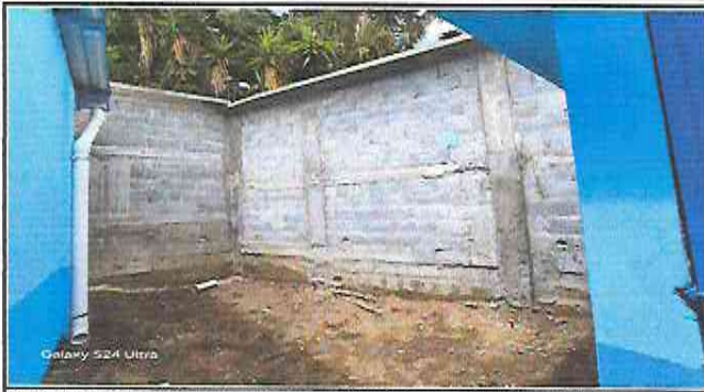
Foto 19: Reparación de muro de contención con su marquesina
