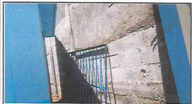
Foto 3: Reparación de muro de contención con su marquesina
