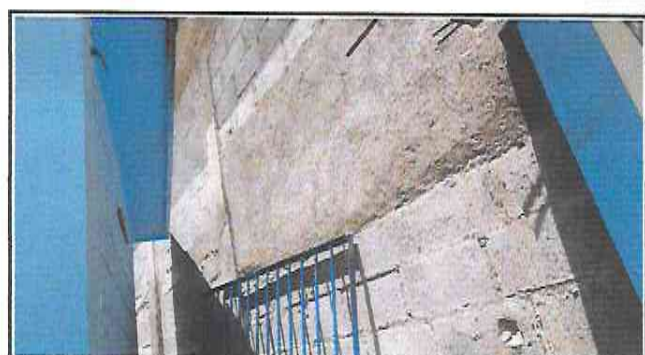
Foto 4: Reparación de muro de contención con su marquesina
