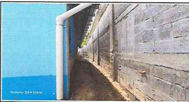
Foto 11: Reparación de muro de contención con su marquesina
