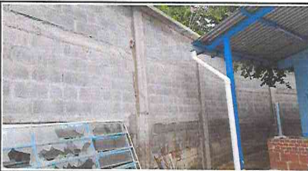
Foto 15: Reparación de muro de contención con su marquesina
