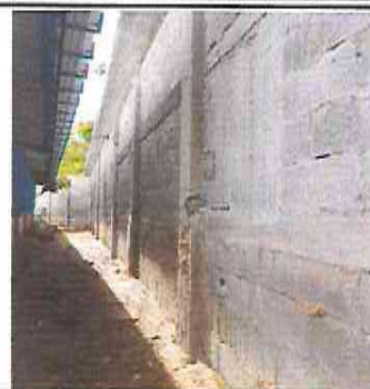
Foto 8: Reparación de muro de contención con su marquesina
