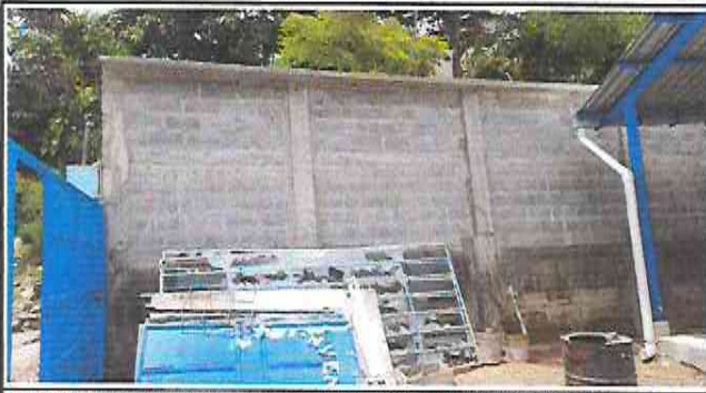
Foto 13: Reparación de muro de contención con su marquesina
