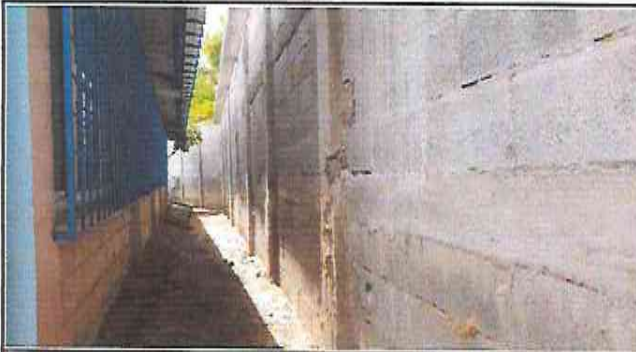
Foto 9: Reparación de muro de contención con su marquesina
