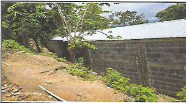
Foto 21: Reparación de muro de contención con su marquesina
