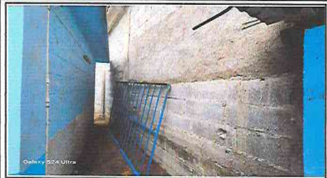
Foto 1: Reparación de muro de contención con su marquesina
