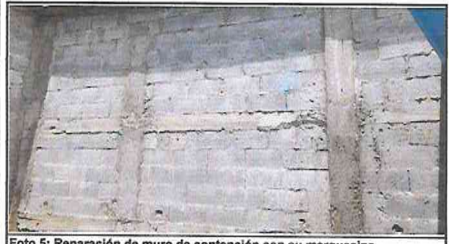
Foto 5: Reparación de muro de contención con su marquesina
