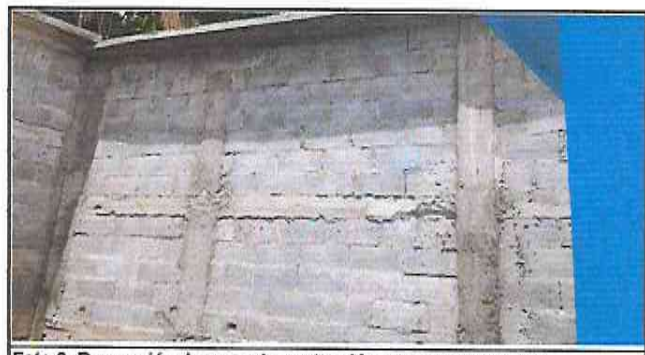
Foto 6: Reparación de muro de contención con su marquesina
