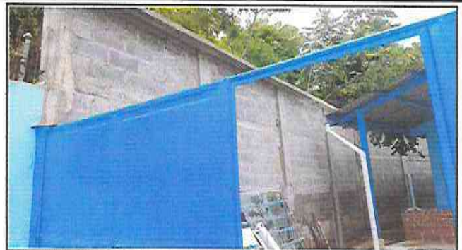
Foto 14: Reparación de muro de contención con su marquesina
