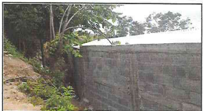
Foto 22: Reparación de muro de contención con su marquesina
