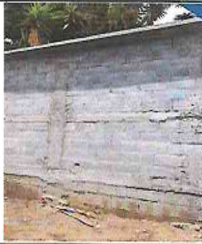
Foto 7: Reparación de muro de contención con su marquesina
