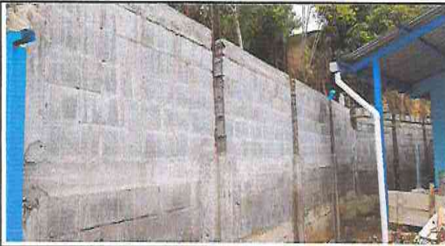
Foto 13: Fundición de columnas, en el muro de contención.
