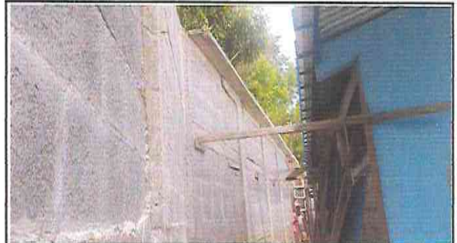
Foto 10: Fundición de marquesina, en el muro de contención.
